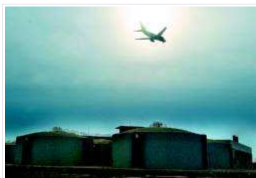
Planta desalinizadora del río Llobregat en El Prat, donde Agbar filtrará el agua, ayer, aún en obras. Foto: JOAN CORTADELLAS
